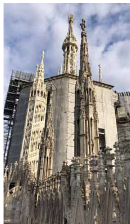
Duomo di Milano, incastellatura del tiburio durante i recenti restauri.
