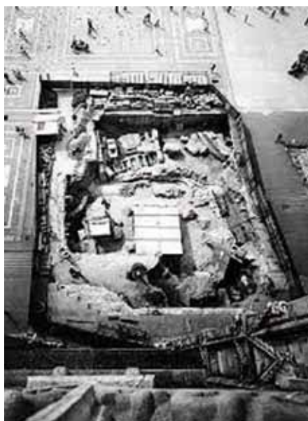
Scavi in piazza del Duomo durante la costruzione della linea 1 metropolitana. L'area del Battistero di San Giovanni alle Fonti viene alla luce
