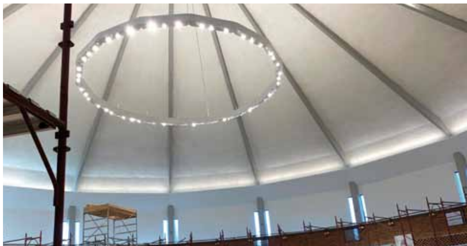
Il lampadario posto su una struttura di sedici lati come gli spicchi della copertura a completare l'illuminazione circolare omogenea che corre alla base della copertura sopra il matroneo. Sotto: la illuminazione particolare puntata sul crocifisso.
