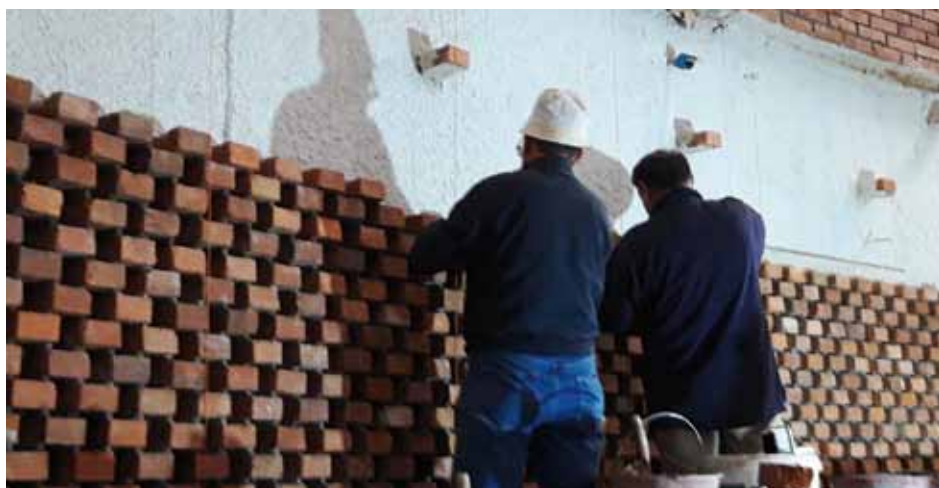
Ad uno ad uno vengono riposizionati i mattoni sanificati sopra il nuovo strato di intonaco isolante (foto di Maria Clotilde Licini)
